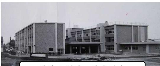
鉄筋3階建の防音校舎
