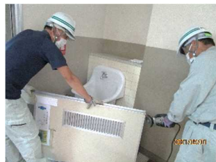
ドア開閉調整、修理
