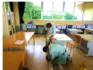
電気配線修繕
