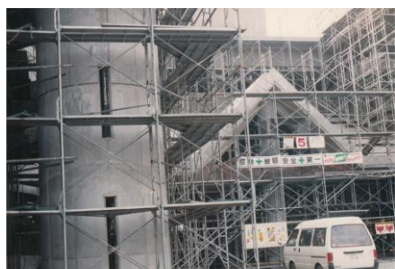
【工事中の昇降口前の様子】
