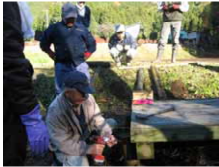
木道の修復風景
