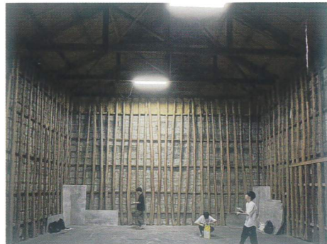
駒生倉庫の内部実測
