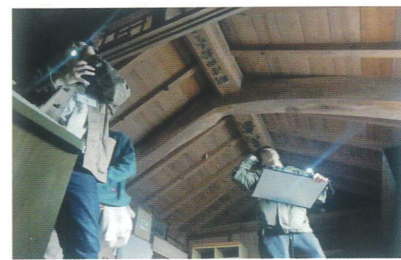
石蔵の内部を実測調査中
