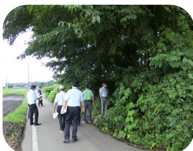
草や樹木が道路まで伸びている
