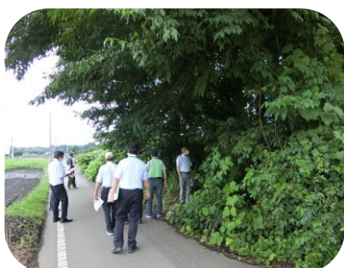
草や樹木が道路まで伸びている
