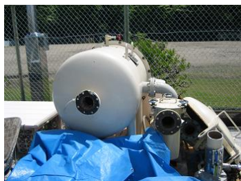
【撤去したろ過設備】
