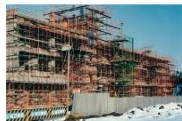
校舎建設の様子 (1984 年頃)
