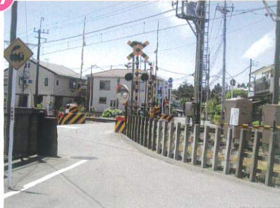
弥生2丁目 宮原5丁目 横断踏切 道路の見通しが悪く、道幅が狭い
