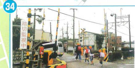
34 花房踏切 踏切が狭い 道が細く死角が多い
