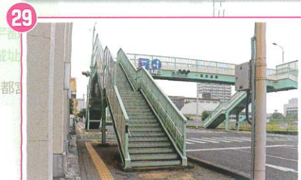
29 足銀横 歩道橋があるため歩道が狭い
