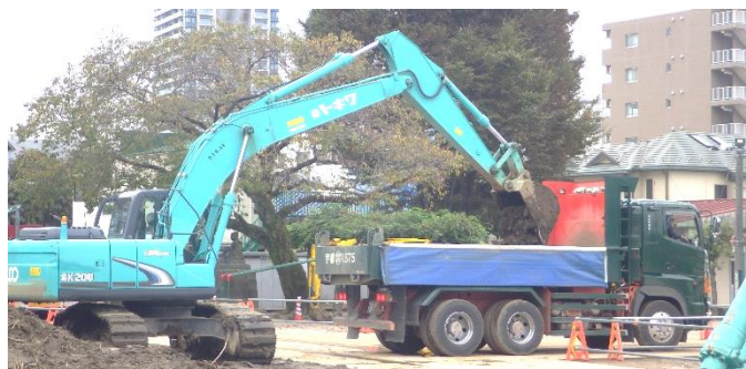
校庭に集められた残土を運び出す大型トラック 【10月21日（月）撮影】
